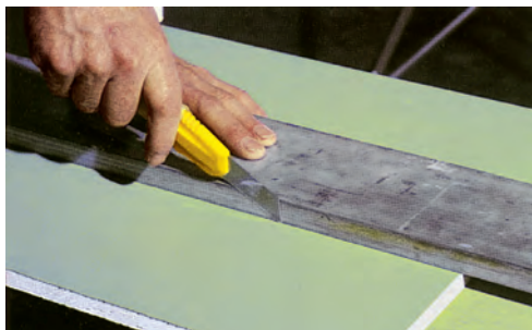
Karton na vidni strani plošče zarezemo ob poravnalni letvi.
