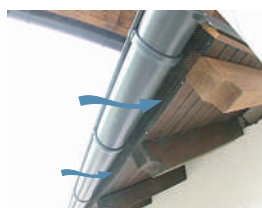
1. Dotok zraka v prezračevalni kanal
