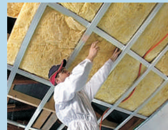
2 Postavimo prvi sloj izolacije
