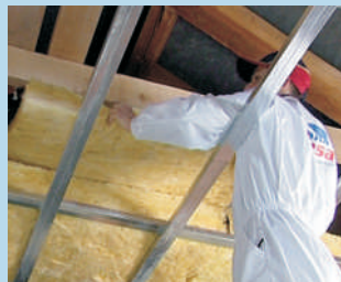
3 Postavimo drugi sloj izolacije
