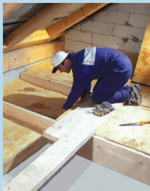
1 Polaganje prvega sloja izolacije med lesene distančnike
