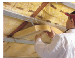
6. Pod kovinski C-profil vstavimo drugi sloj izolacije
