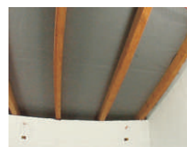
2. Predhodno položena paroprepustna folija – sekundarna kritina
