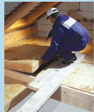
2 Polaganje drugega sloja – pri razrezu izolacije v plošče, dodajte 2 cm nadmere.
