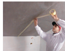
8. Vse spoje, preboje in priključke na foliji moramo zalepiti
