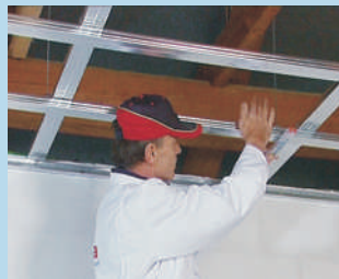
1 Postavimo kovinsko konstrukcijo
