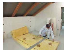
4. Izolacijo razrežemo na primerno velike plošče
